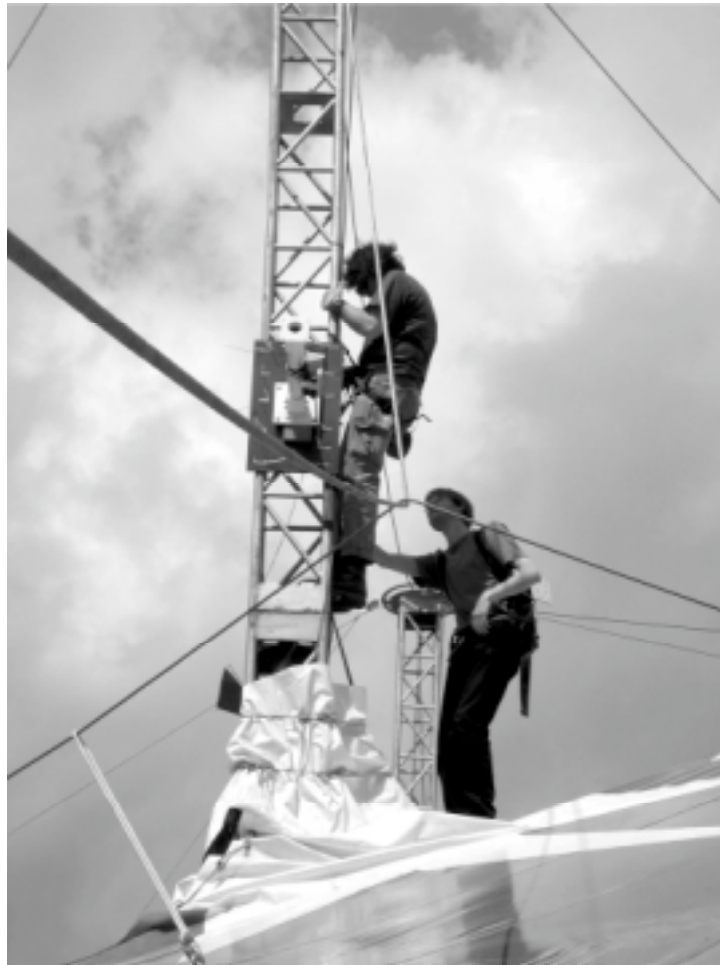
Bild 3. NetEverywhere Roland Kubica oben bei der Montage einer optischen Richtfunkanlage
