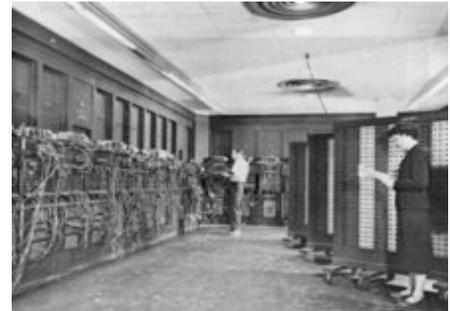
Der ENIAC hatte zu dem auch eine hohe Ausfallzeit, da die Elektronenröhren keine lange Lebenszeit hatten und wenn nur eine der vielen ausfällt ist die ganze Rechnung fehlerhaft. Da man bemerkte, dass diese hauptsächlich beim an und ausschalten der Anlage den Geist ausgaben beschloss man den ENIAC einfach nicht mehr auszuschalten, was natürlich sehr hohe Stromkosten verursachte, allerdings die Ausfallzeit in einer Woche auf ein paar Stunden reduzierte.
